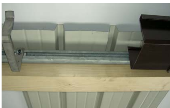
Sistema di fissaggio con profili tipo „Halfen“ su parete!
