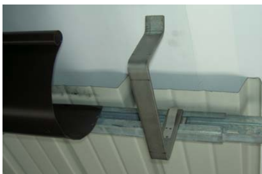
Sistema di fissaggio con profili tipo „Halfen“ su grecate in sporgenza senza travi
