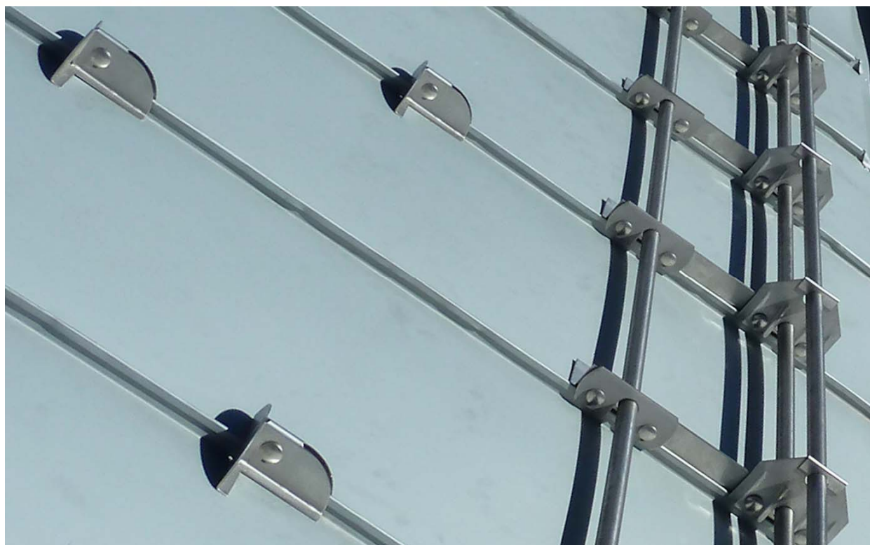
Dreifachrohr in Inox für Traufkantenschutz und Schneenasen in Inox für Doppelstehfalzeindeckung
