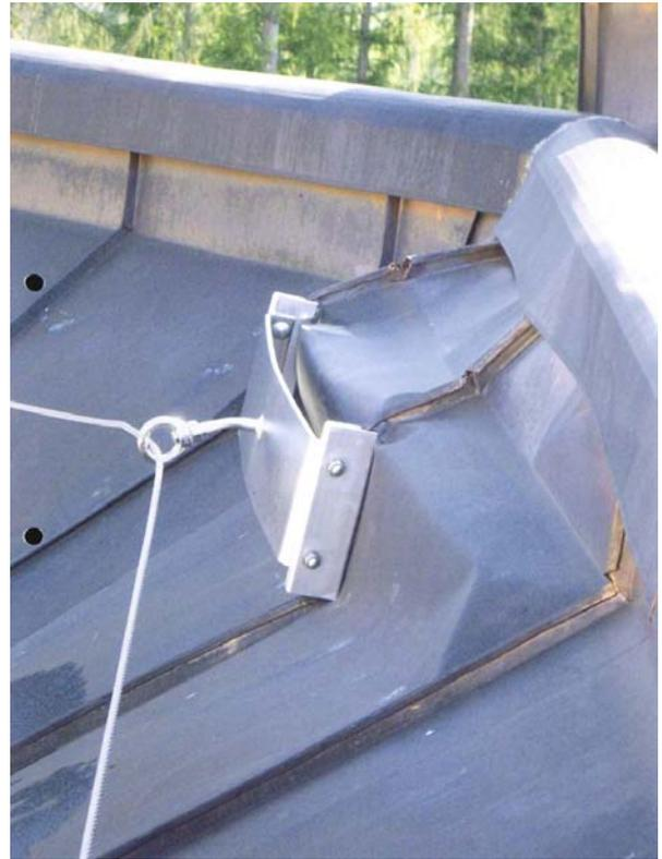
Schäden der Doppelstehfalzeindeckung durch falsche Positionierung der Anker und fehlenden Schneeschutzes laut Vorgaben SA.
