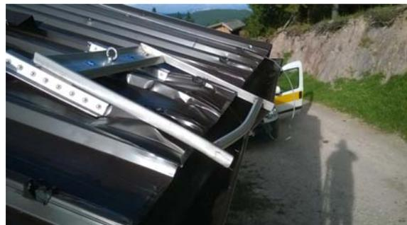
Schäden an Anschlagpunkten und Trapezblech wegen fehlenden Schneeschutzes laut Vorgaben SA.
