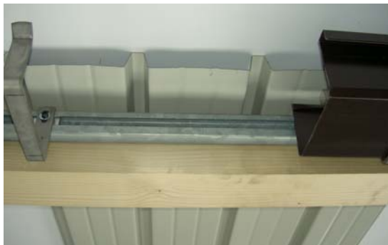
Befestigungssystem mit Halfenprofile auf der Wand!
