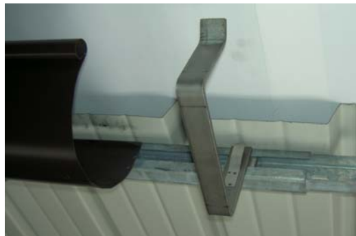
Befestigung mit Halfenprofile auf Trapezblechbahnen im Vorsprung ohne Sparren
