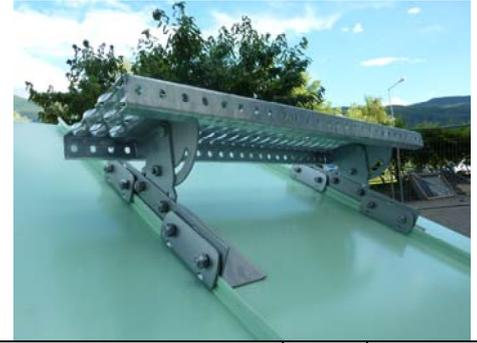
Berechnung für eine Stufe : 2 x Laufroststütze + Laufrost x Länge
