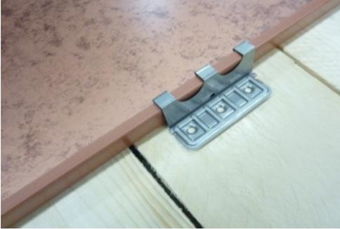
6) Mit dem Zeigefinger die mittlere Haftzunge schließen.
