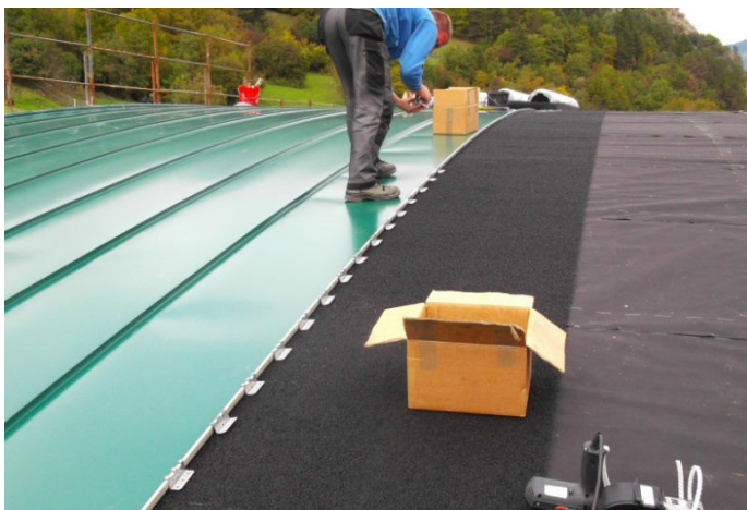
Eindeckung ohne Spannungen. (System SA)
